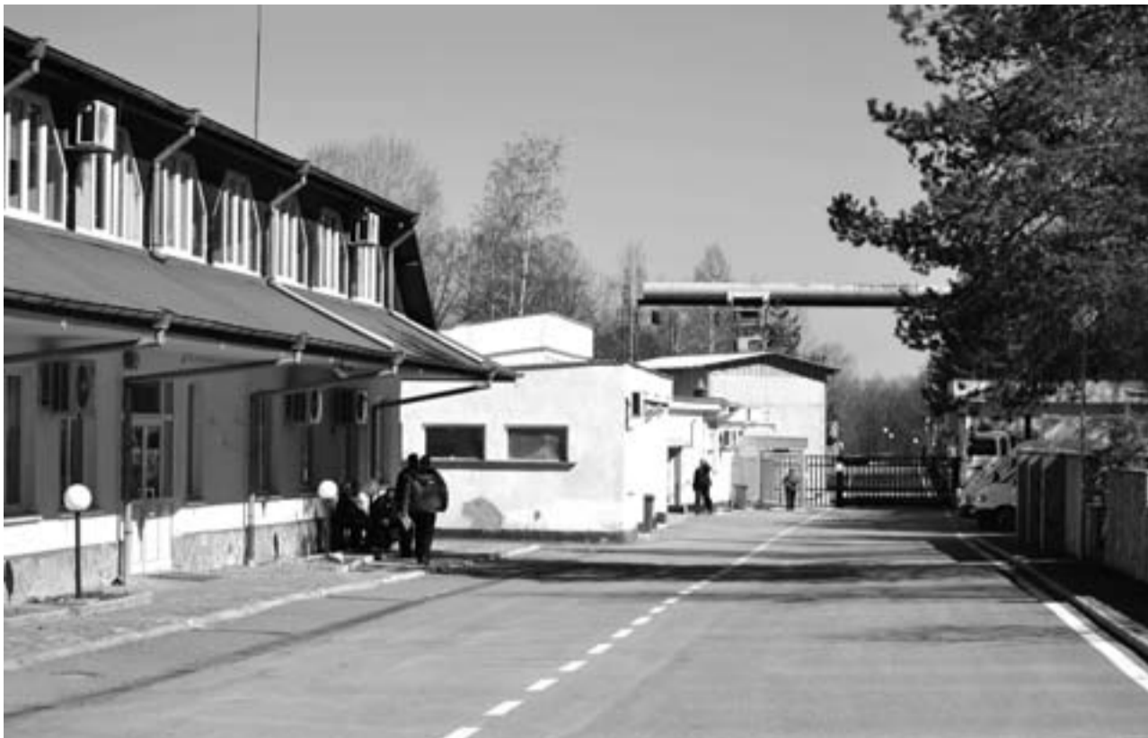
общ изглед хранилище
