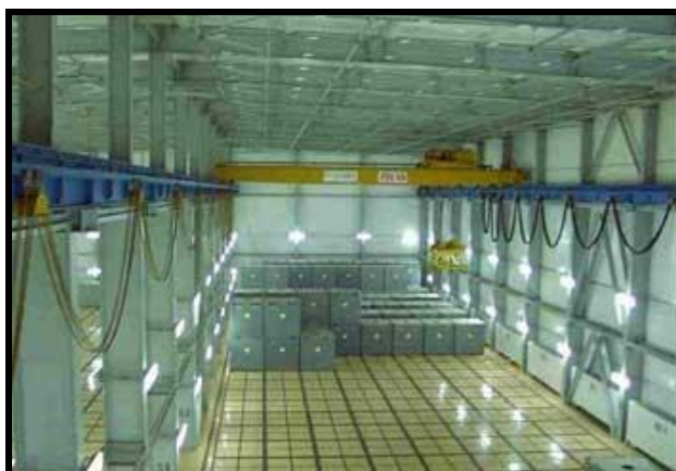
FIGURĂ 2.2-5 DEPOZITARE TEMPORARĂ ÎN DPPDRA PE ȘANTIERUL CENTRALEI NUCLEARO-ELECTRICE „KOZLODUI”
