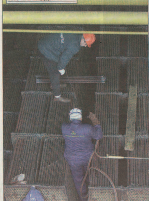
До момента са демонтирани 2800 тона оборудване.
